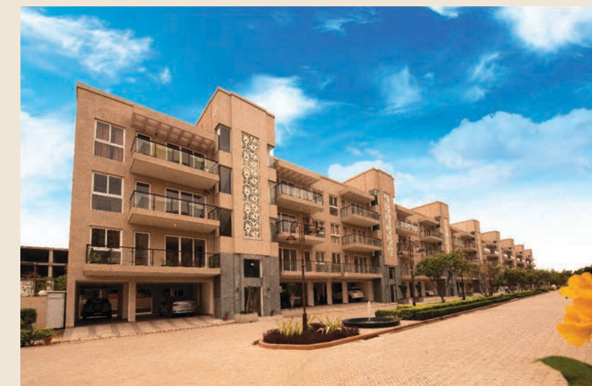
Actual photo of Pedestal, Sector 70A - Gurugram
